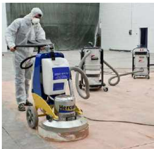
Separatori mobili con scarico Longopac per trattamento superfici | Separators with Longopac discharge system for floor preparation
